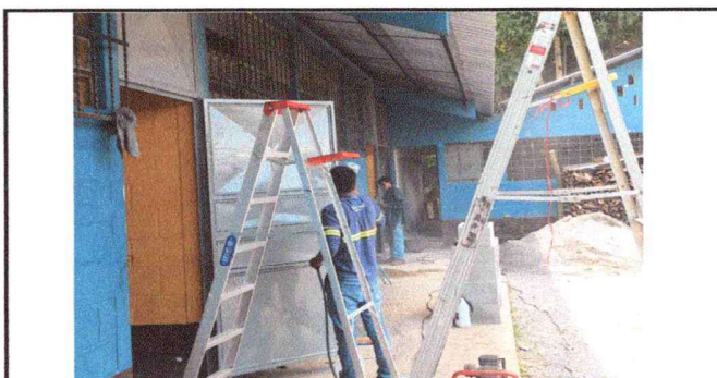
Foto 6: Reparando puertas de metal
