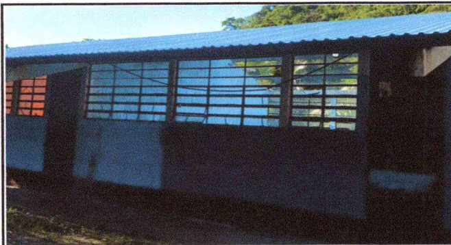
Foto 4: Intalando cables electricos
